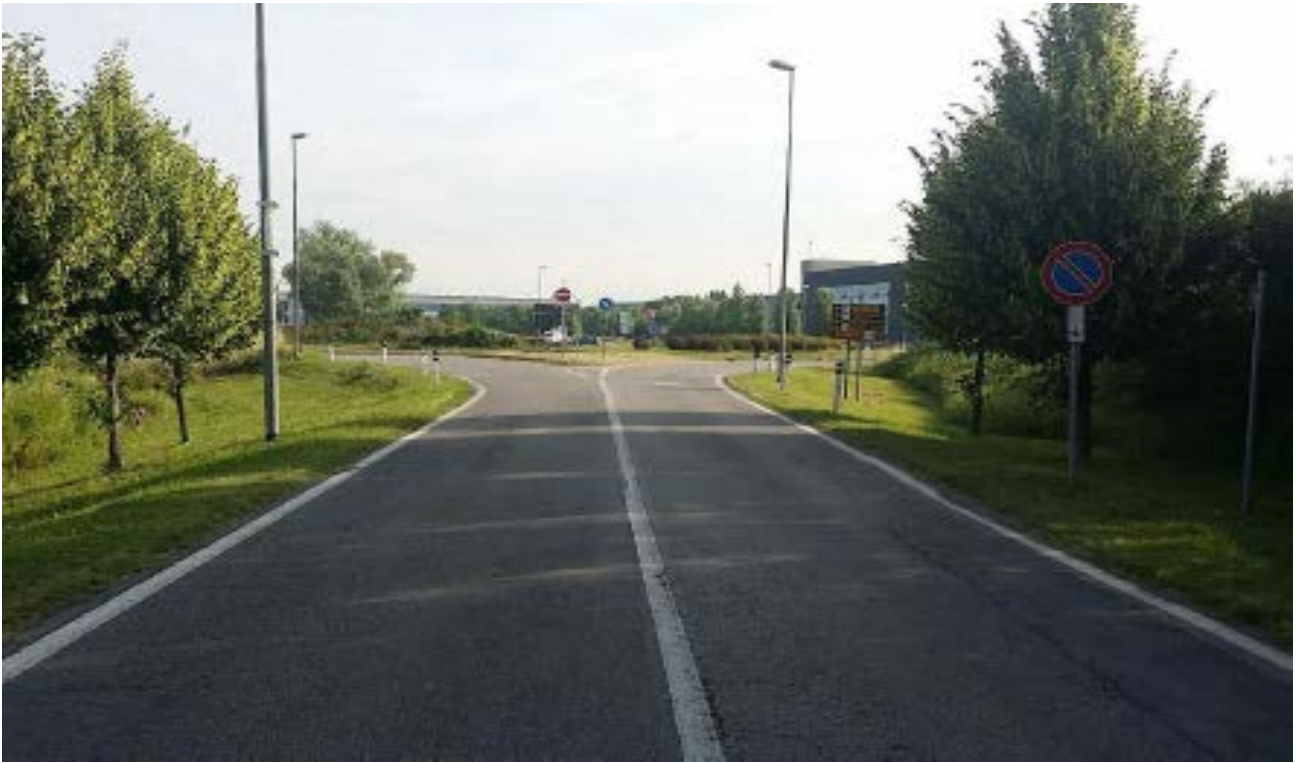
Intersezione 5 tra SP 14, via Verona e via Firenze, ramo via Firenze
