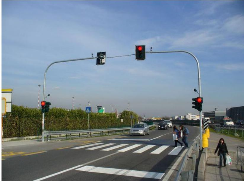
Figura 4 – Immagine tipo impianto semaforico a chiamata
