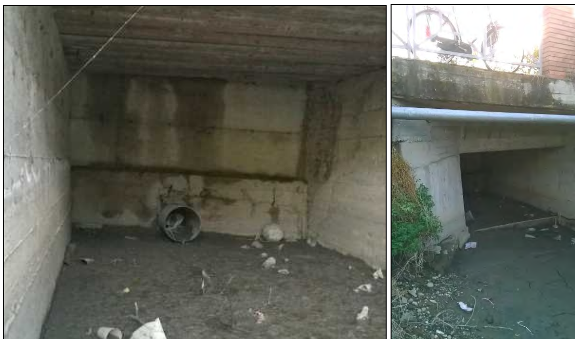
Figura 102 imbocco tratto tombinato e soglia in legno da sostituire sotto al ponte foto fornita da Comune di Vignate
