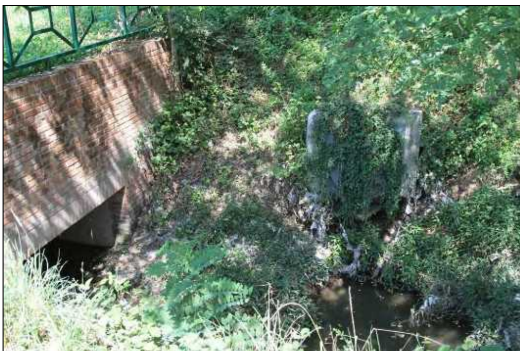
Figura 89 scarico e depositi a valle del tratto intubato
