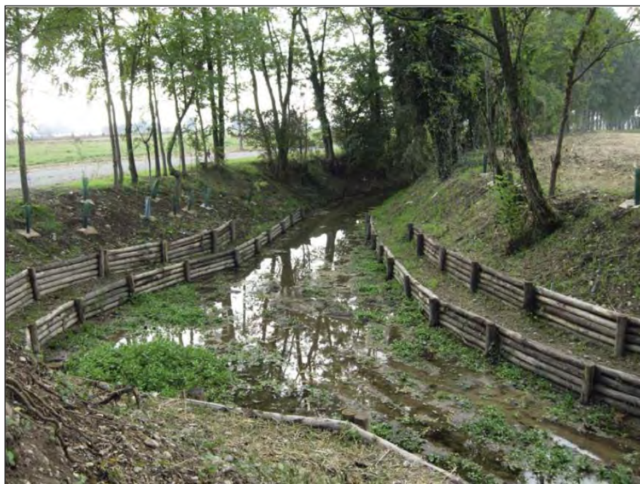
Figura 12 consolidamento sponde (tratto da Quaderni ricerca n.144 Marzo 2012 Fonte)
