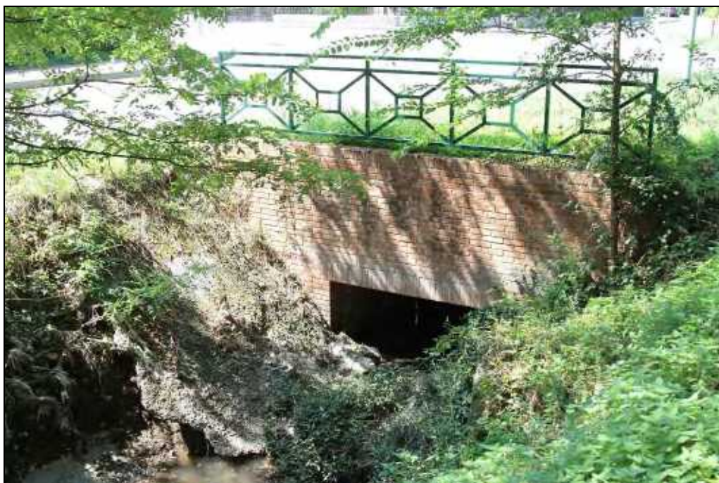
Figura 88 manufatto di attraversamento strada e platea scalzata al piede
