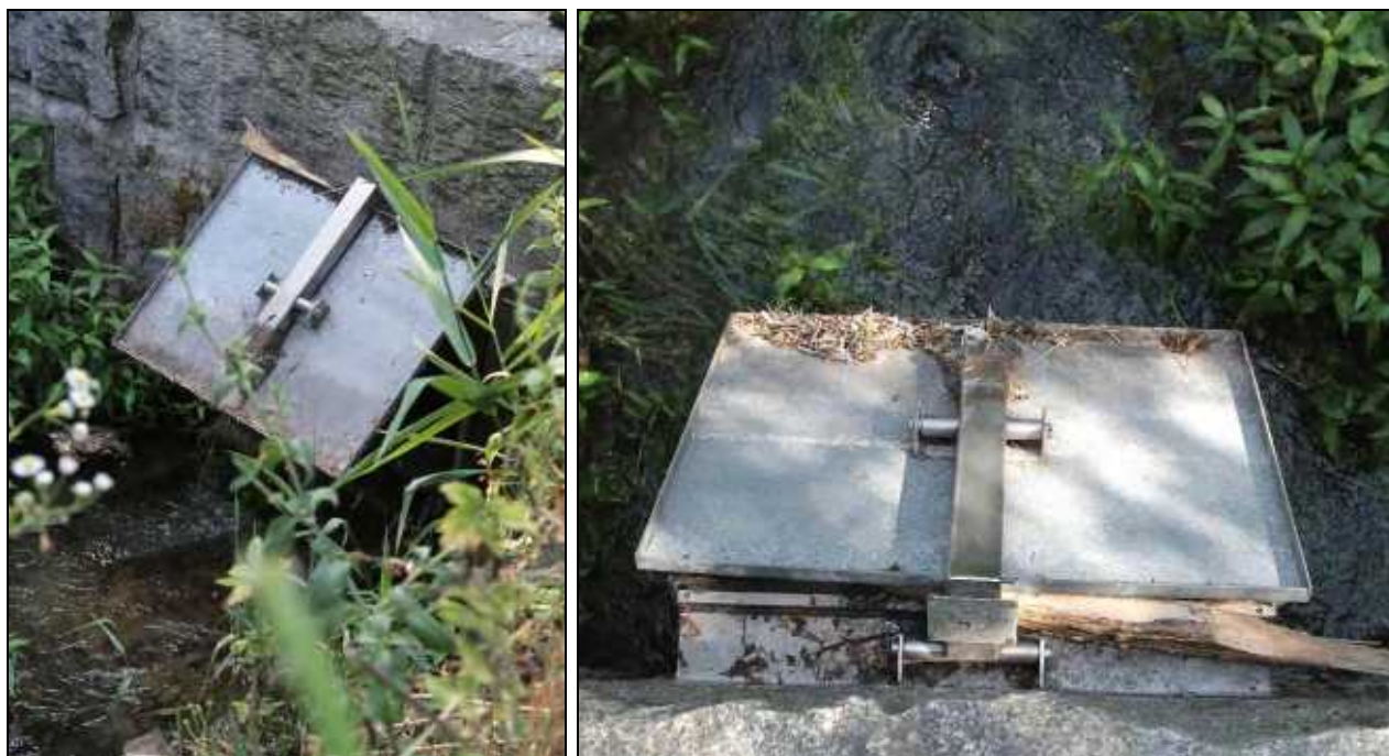
Figura 118 valvola a clapet sulla briglia in massi (lato valle) e vista dall'alto
