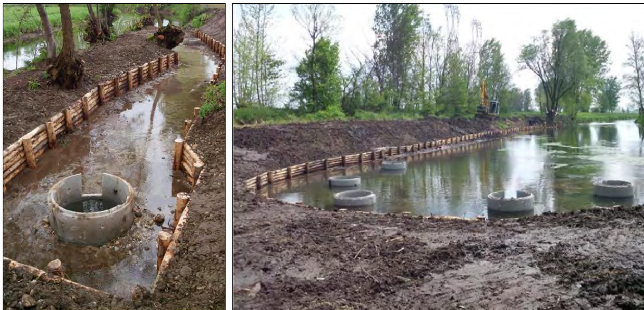
Figura 7 esempio di tini appena posati
