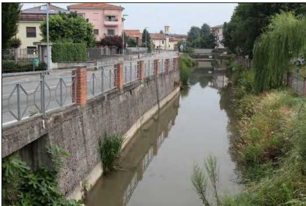
Figura 101 il tratto in destra idrografica (sinistra in figura) verrà ristretto con una scogliera sormontata da una palificata semplice
