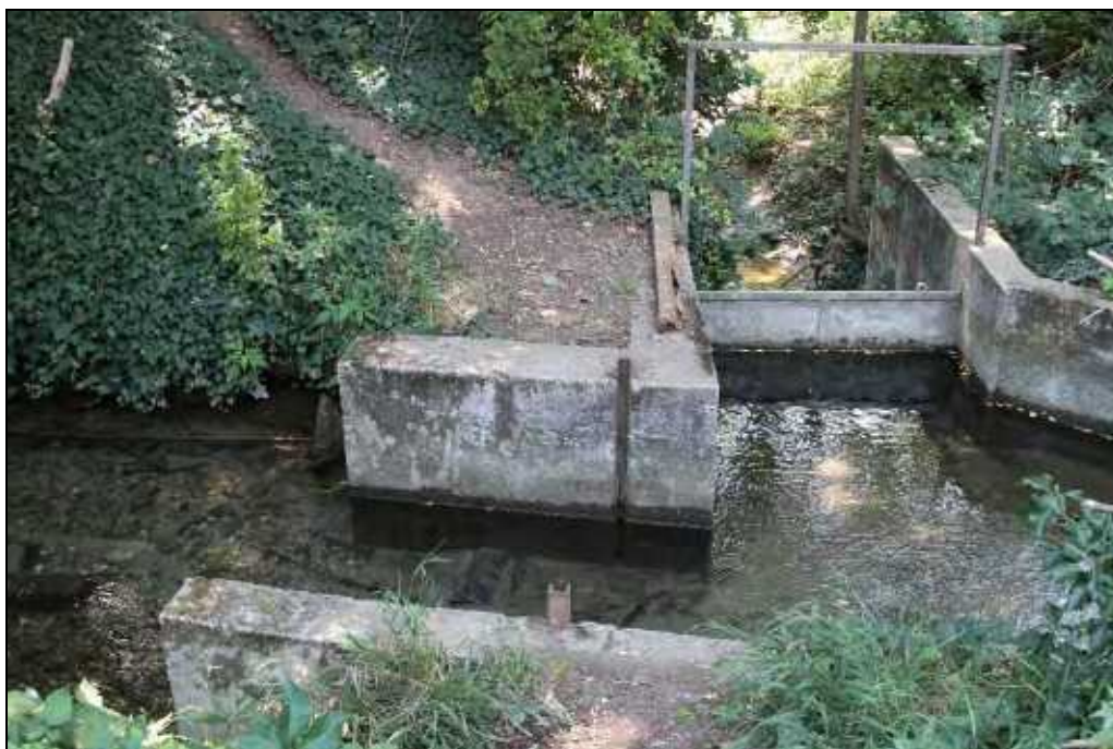
Figura 59 paratoia lungo il canale irriguo a monte del fontanile
