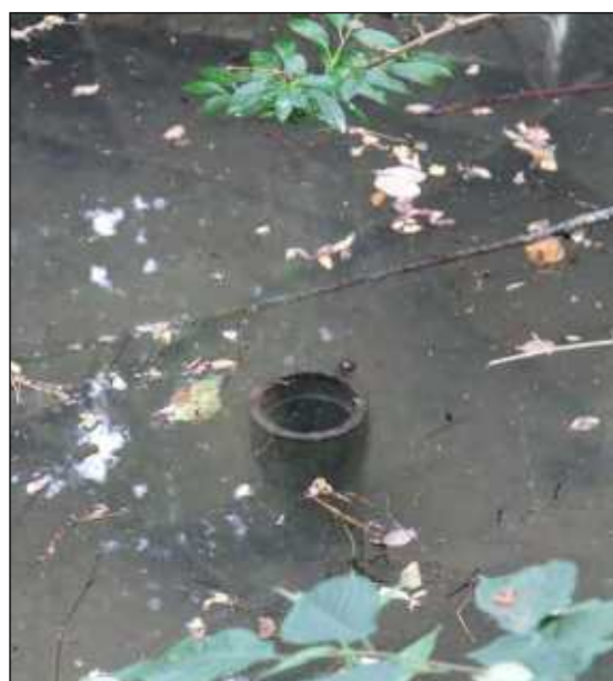
Figura 30 tino e tubo intasati in sponda sinistra
