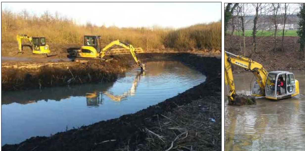
Figura 9 escavatori in azione dalla sponda e sul fondo della testa del fontanile
