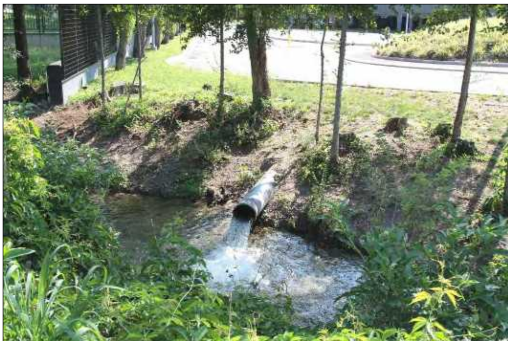
Figura 37 tubo di scarico delle acque di un impianto geotermico
