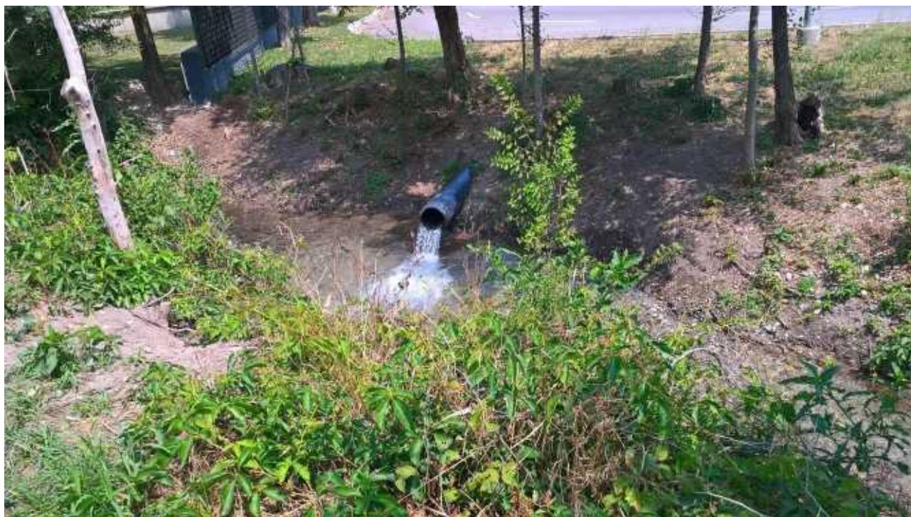
Figura 46 scarico di un impianto di geotermia
